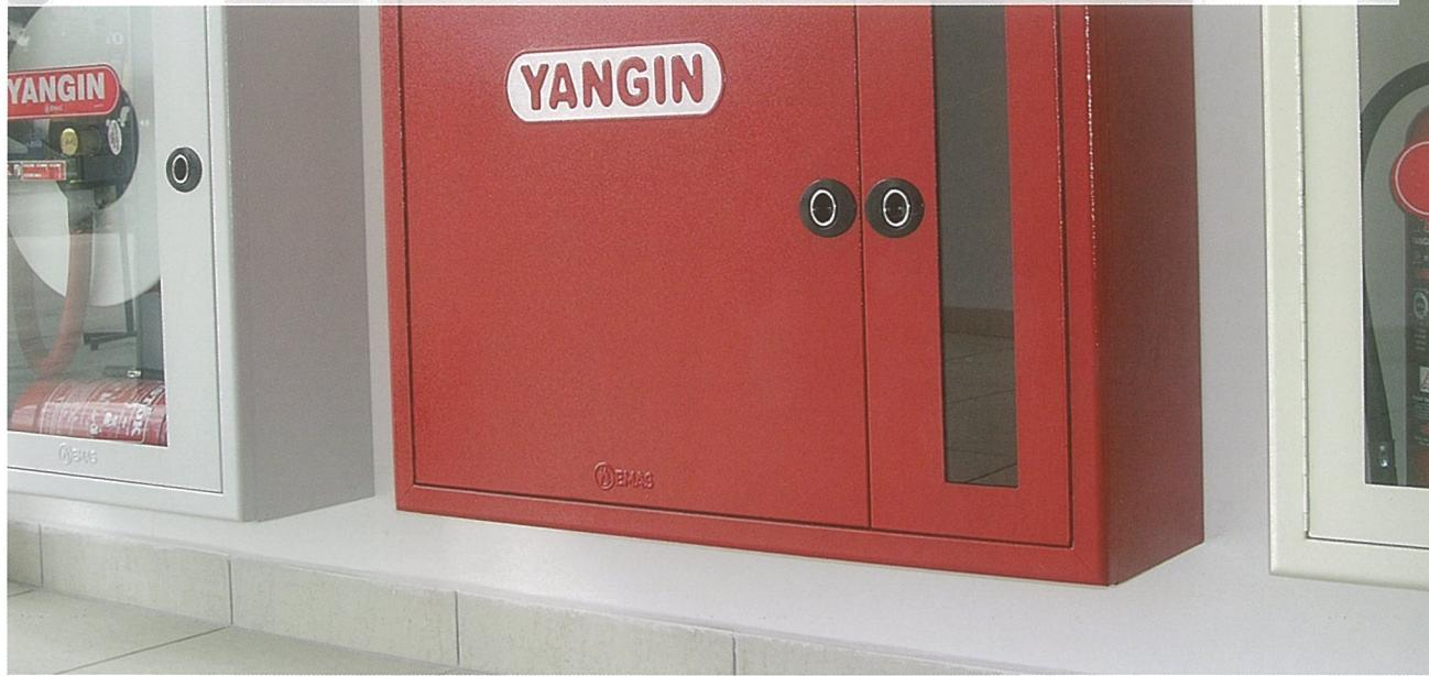
Yangın Dolap Tesisatın amacı; bina içinde yanın ile mücadelede güvenilir ve yeterli suyun sağlanmasıdır. Bunun için, bina içinde itfaiye su alma hattı ve yanın dolapları tesis edilir.
