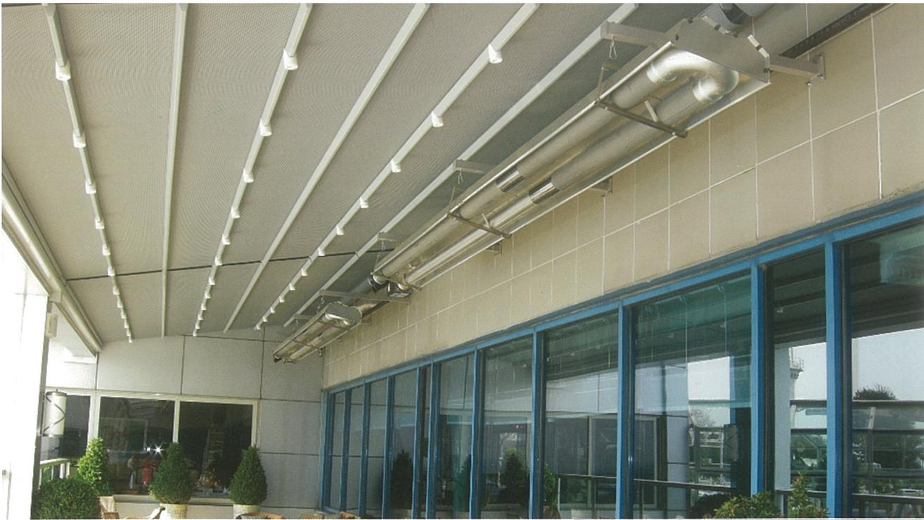
Açık alan ısitması için özel olarak dizayn edilmiş borulu ve seramik plakalı radyan ısitıcılar....
