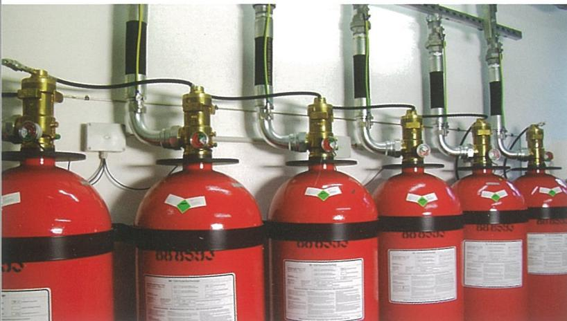
Gazlı yanın söndürme sistemleri, Halon alternatif olarak en yaygın kullanılan temiz gazdır.
